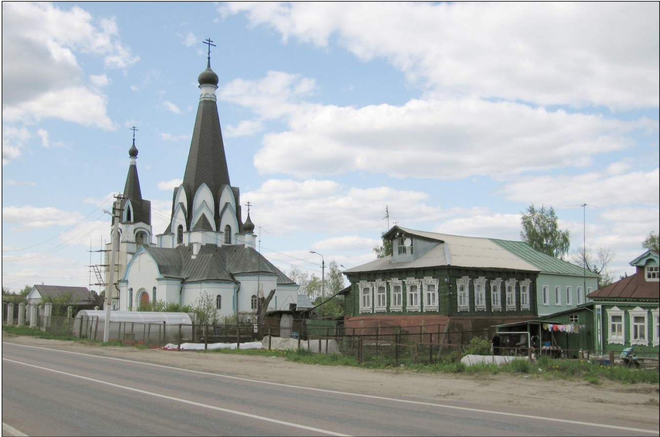
Вид на церковь с Егорьевского шоссе с запада (т 2)
