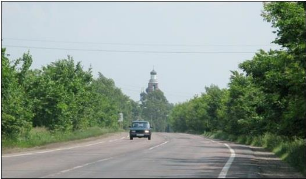
Вид на церковь с Егорьевского шоссе с северо-запада (т.11)
