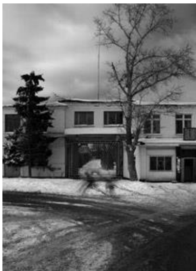
Проходная Кузьевского Фарфорового завода.
