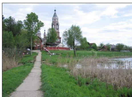
Вид на церковь с северо-запада (т 2)
