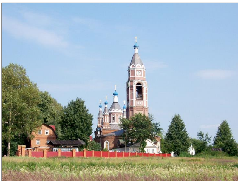
Церковь Георгия Победоносца в селе Игнатьево. Фото с западной стороны
