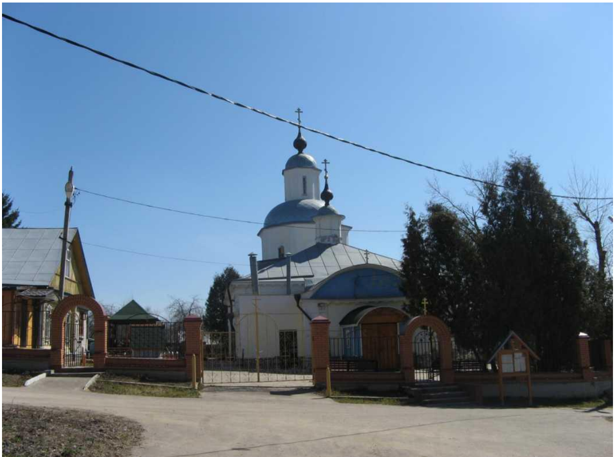
с.Татаринцево. Вид на церковь Животворящего Креста с запада, с главного входа.
