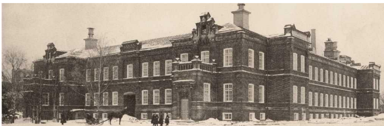
Фабричная школа (фото 1900-х годов). Вид с юго-востока на главный фасад
