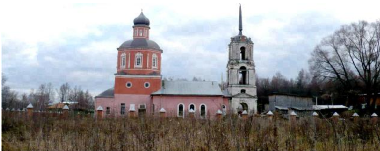
Усадьба «Никитское». Церковь Владимирская, нач.18в., сер.18в., 1838г., 1886г. Вид на северный фасад.
