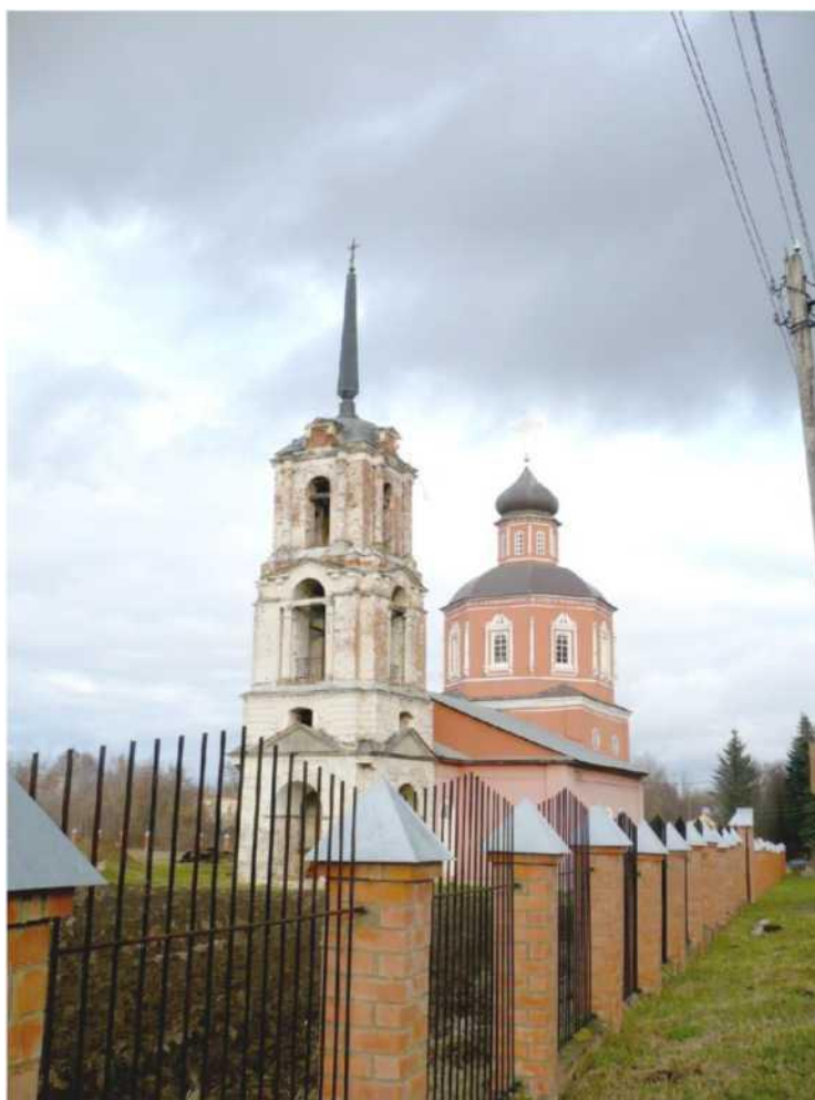
Усадьба «Никитское». Церковь Владимирская, нач.18в., сер.18в., 1838г., 1886г. Западный фасад.
