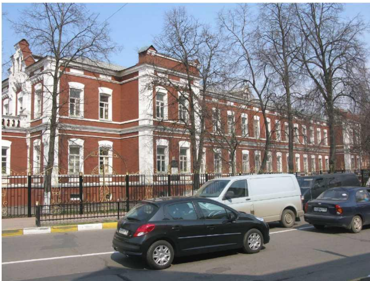
Вид с юго-востока на восточный фасад
