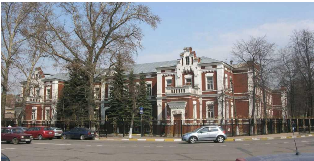
Здание, где на собраниях выступали председатель ВЦИК М.И.Калинин, нарком просвещения А.В.Луначарский, председатель Центробалта П.Е. Дыбенко, 1920-е годы. Здание фабричной школы, 1900 год. Вид с юго – востока
