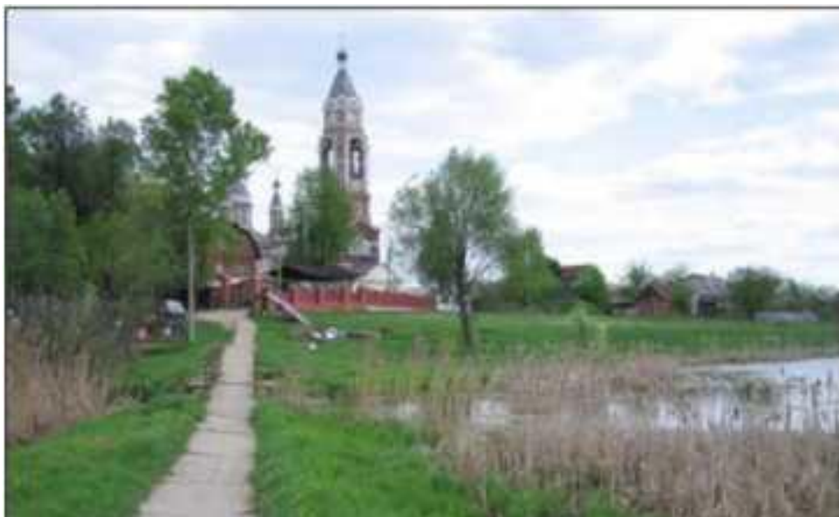
Вид на церковь с северо-запада (т 2)
