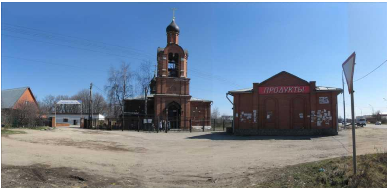
с. Боршева. Вид на церковь Святителя Николая с запада. Справа - Рязанское шоссе.
