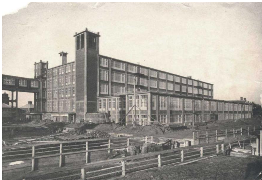
Строительство бетонного корпуса Раменской фабрики 1910-е годы (не сохранился)
