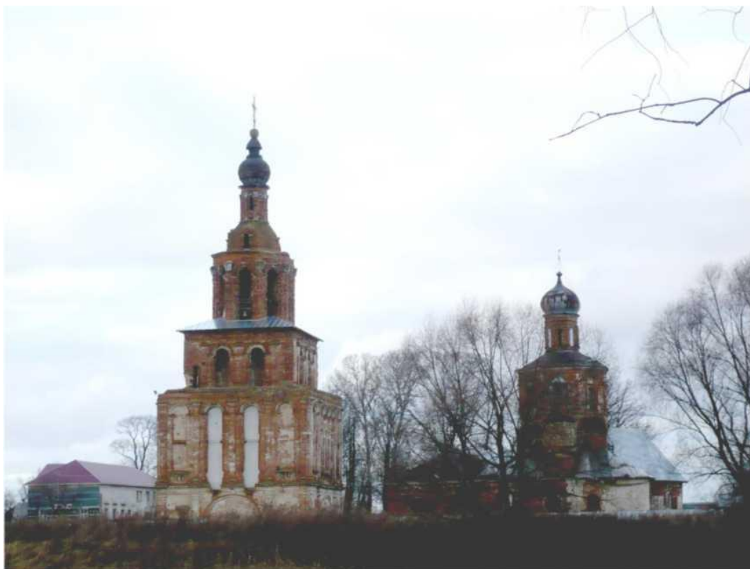
с. Степановское. Церковь Благовещения и колокольня, 1732г. Северный фасад.
