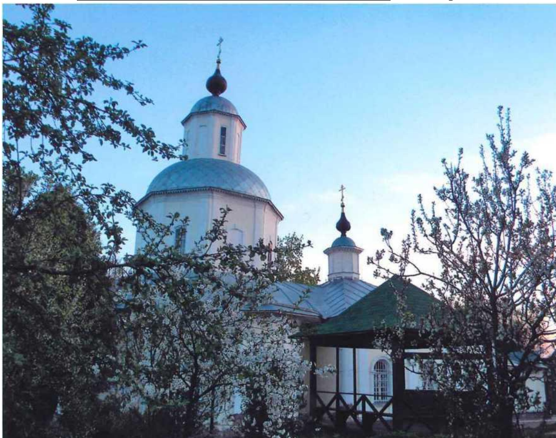
С.Татаринцево. Вид на церковь Животворящего Креста с северо-востока.
