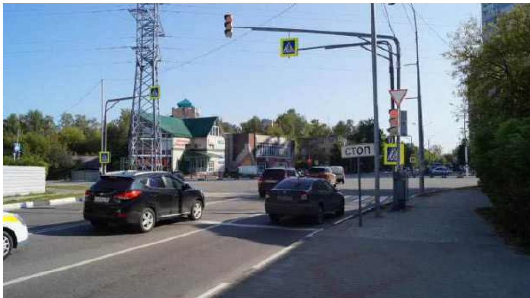
Рисунок 1.8.17 – Наглядное представление существующей схемы ОДД на пересечении Чугунова ул. - Спортивный пр-д - Левашова ул.
