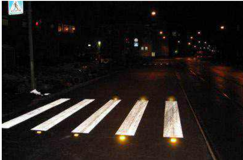
Рисунок 4.5.4 – Пример совместного использования дорожной разметки и световозвращателей
