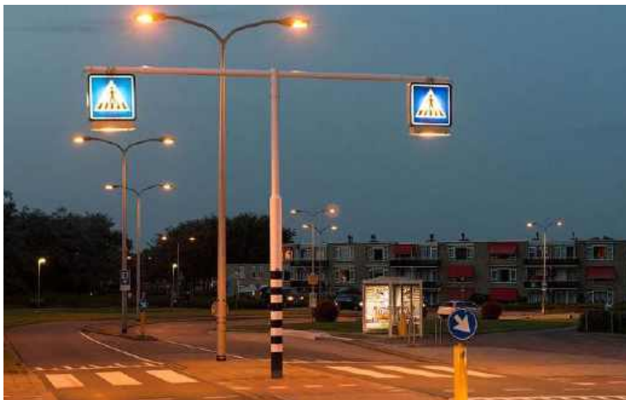
Рисунок 4.5.2 – Пример дорожных знаков 5.19.1, 5.19.2 с встроенными светодиодными светильниками уличного освещения
