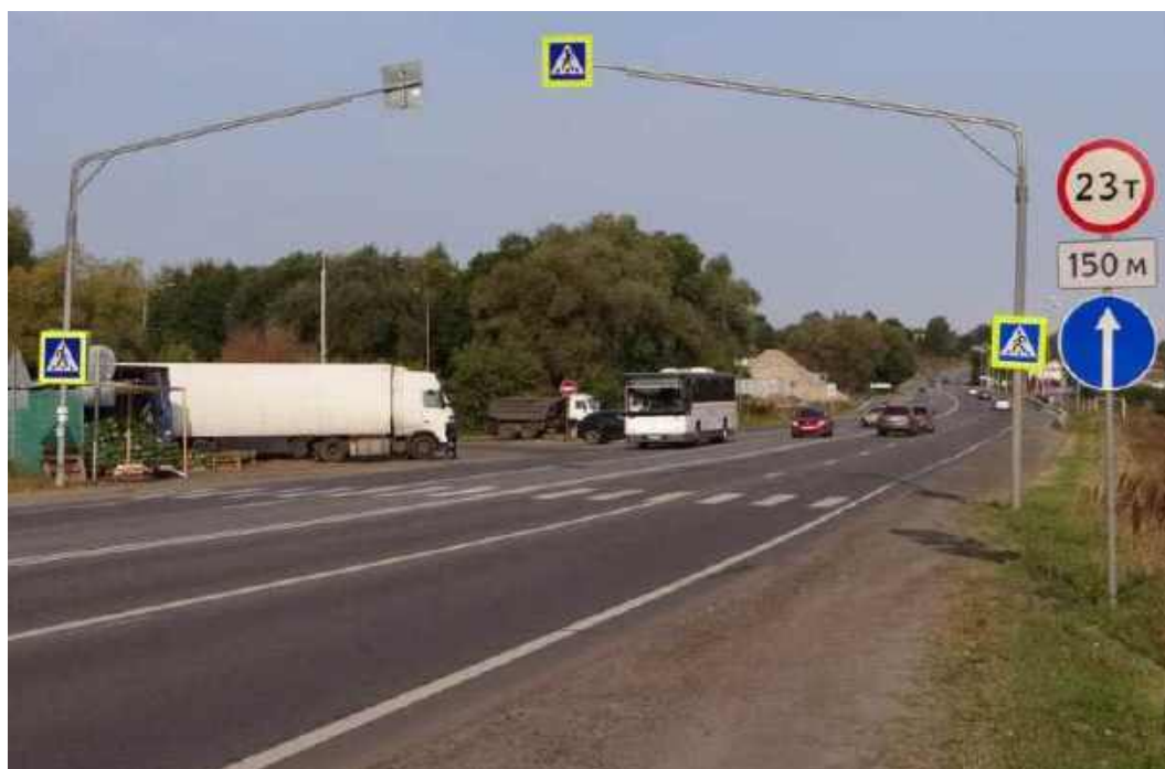
Рисунок 1.8.42 – Наглядное представление существующей схемы ОДД на пересечении Старое-Рязанское ш. - а/д на Денежниково
