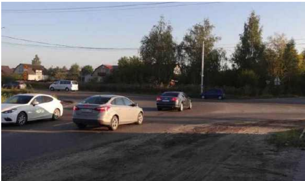
Рисунок 1.8.35 – Наглядное представление существующей схемы ОДД на пересечении Шоссейная ул. - проезд к 46К-5300
